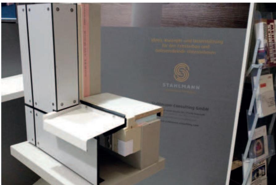
**Bei diesem Bild sieht man die fertige Aussenfassade angeschlossen an der Zarge mit allen erforderlichen Abdichtungsmaßnahmen, ohne das das Fenster eingebaut ist. Auch die Innen- und Außenfensterbänke sind bereits fertig montiert. Bei der dargestellten Fassade handelt es sich um eine hinterfüllte Fassade. Alternativ wäre in gleicher Art und Weise auch ein Vollwärmeschutz möglich. Erkennbar ist, dass die anschließenden Gewerke getrennt von eigentlichen Fenster sind.**
