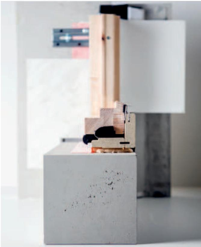
**Horizontalschnitt der Montagezarge montiert in der Leibung. Hier ist das Fenster eingebaut. Man sieht, dass unabhängig vom Fenster diverse Bezugskanten an der Zarge bestehen an denen komplett die äußeren und inneren Gewerke anschließen können. Das Fenster wird nach Fertigstellung der anschließenden Gewerke nur noch in der Zarge mit entsprechender Abdichtung montiert.**
