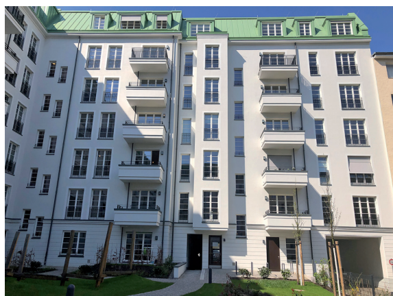
Bauvorhaben „Am Hochmeisterplatz“ in Berlin
